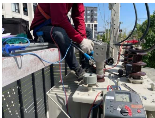
ภาพที่ 3-30 ตรวจสอบและซ่อมบำรุง หม้อแปลงไฟฟ้า
