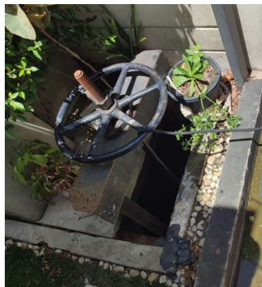
ภาพที่ 3-11 บ่อพักขยะ และบ่อตรวจคุณภาพน้ำมีตะแกรงเหล็กดักขยะภายในบ่อ
